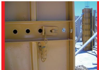
Fixation des plaques avec clavette
